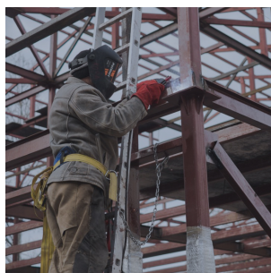
Строительство, монтаж металлоконструкции
