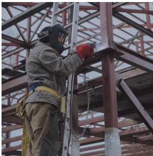
Строительство, монтаж металлоконструкции
