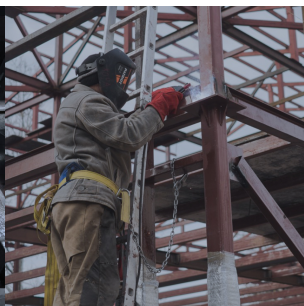
Строительство, монтаж металлоконструкции
