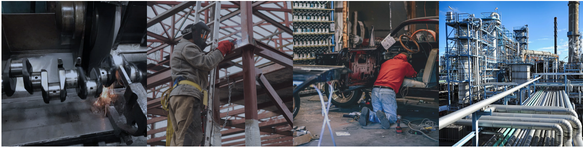
Ремонт и восстановление деталей
