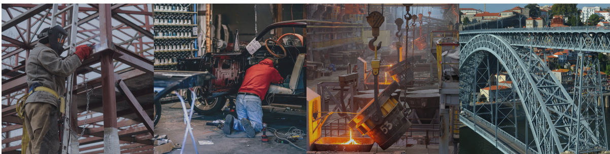
Строительство, монтаж металлоконструкции
