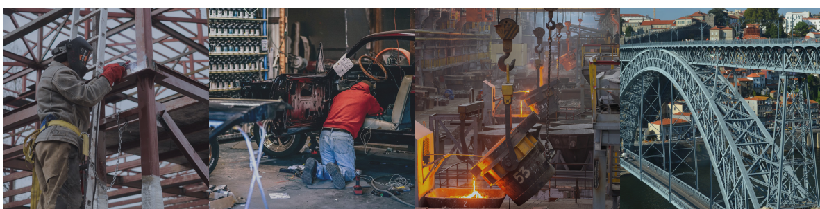
Строительство, монтаж металлоконструкции
