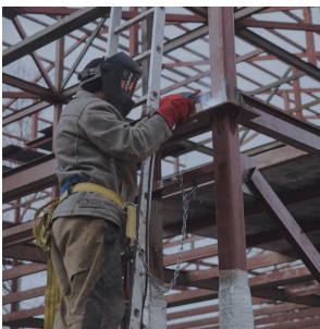
Строительство, монтаж металлоконструкции
