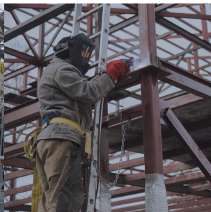
Строительство, монтаж металлоконструкции
