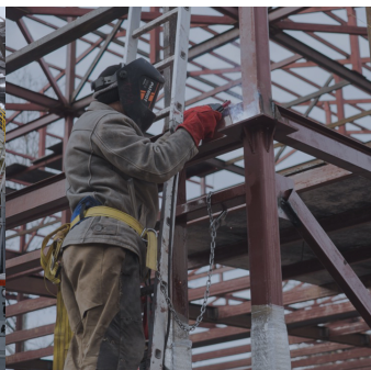
Строительство, монтаж металлоконструкции
