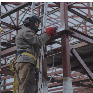
Строительство, монтаж металлоконструкции
