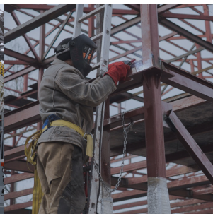
Строительство, монтаж металлоконструкции
