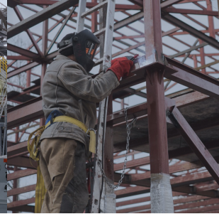
Строительство, монтаж металлоконструкции
