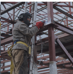
Строительство, монтаж металлоконструкции
