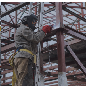
Строительство, монтаж металлоконструкции
